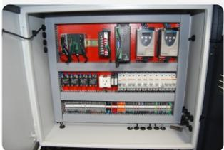
Tablero con PLC, Inverters, Relays de Estado Sólido y termomagnéticas. Estos elementos permiten comandar velocidades y temperaturas con gran confiabilidad y precisión; También reducen el mantenimiento
