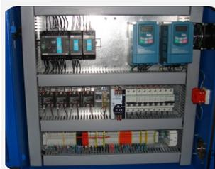
Tablero con PLC, Inverters, Relays de Estado Sólido y termomagnéticas. Estos elementos permiten comandar velocidades y temperaturas con gran confiabilidad y precisión; También reducen el mantenimiento.
