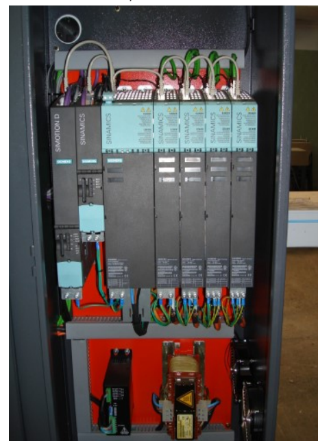
Control de movimiento Simotion, con sus drivers Sinamics S120 a través de Drive-click
